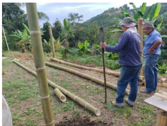
Limpieza del terreno, toma de medidas para realizar su respectivo encierro.
